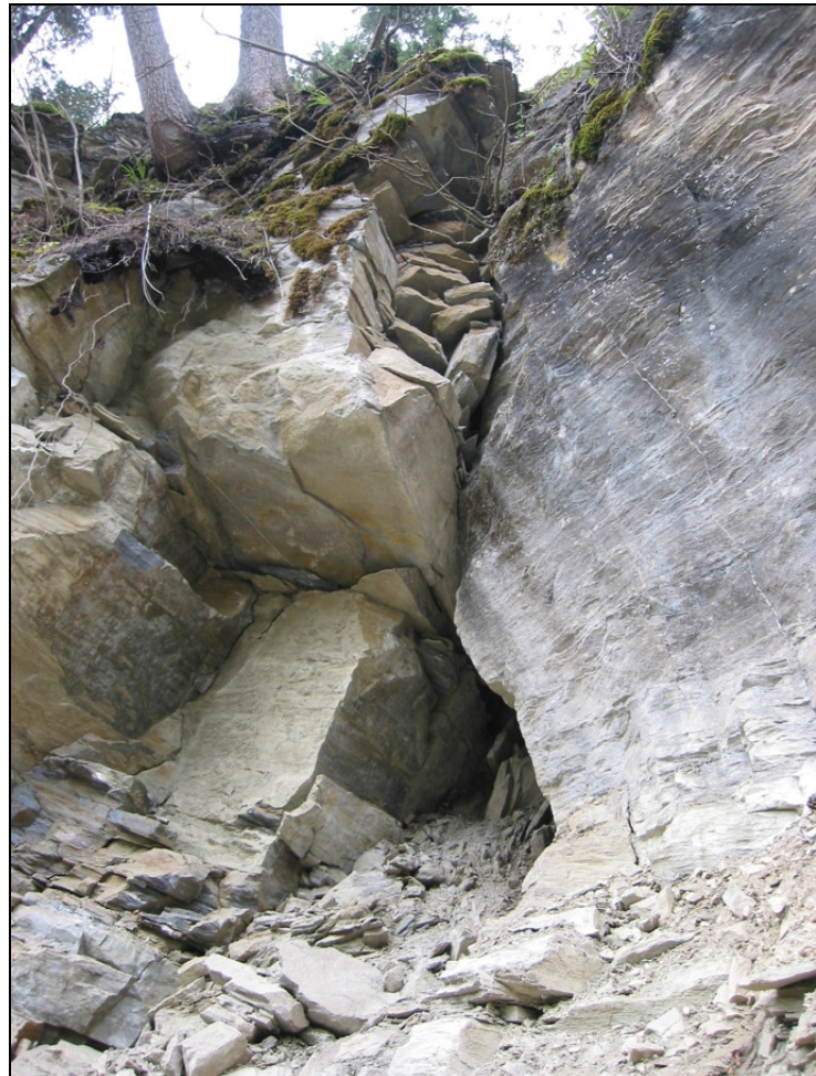
Abb. 5-20: Ansicht des Hauptabrisses im Aufschlussbereich IV auf 1005 Meter ü. NN. Ansicht von Nordosten.
