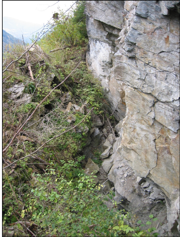
Abb. 6-9: Abrissbereich der Aufschlusszone IIIb. Ansicht von Nordwesten.
