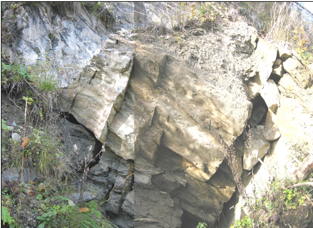
Abb. 6-10: Block in der Abrisspalte der Aufschlusszone IIIb. Ansicht von Südosten.
