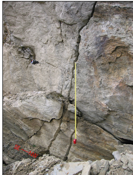
Abb. 6-4: Versatz im Aufschlussbereich II oberhalb des hangparallelen Abrisses. (Maßband = 1 Meter)
