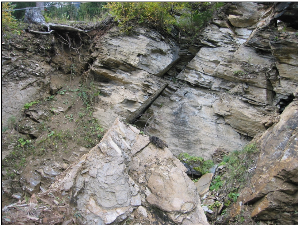
Abb. 9-4: Hauptabrissspalte der Aktivitätszone 1, östlicher Bereich.
