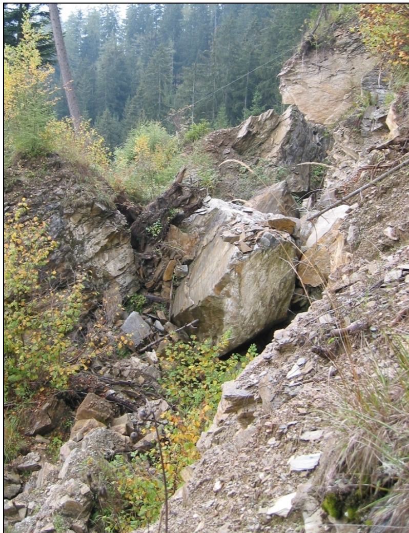
Abb. 5-2: Ansicht des Hauptabrisses der Aktivitätszone 1. Ansicht von NNW.
