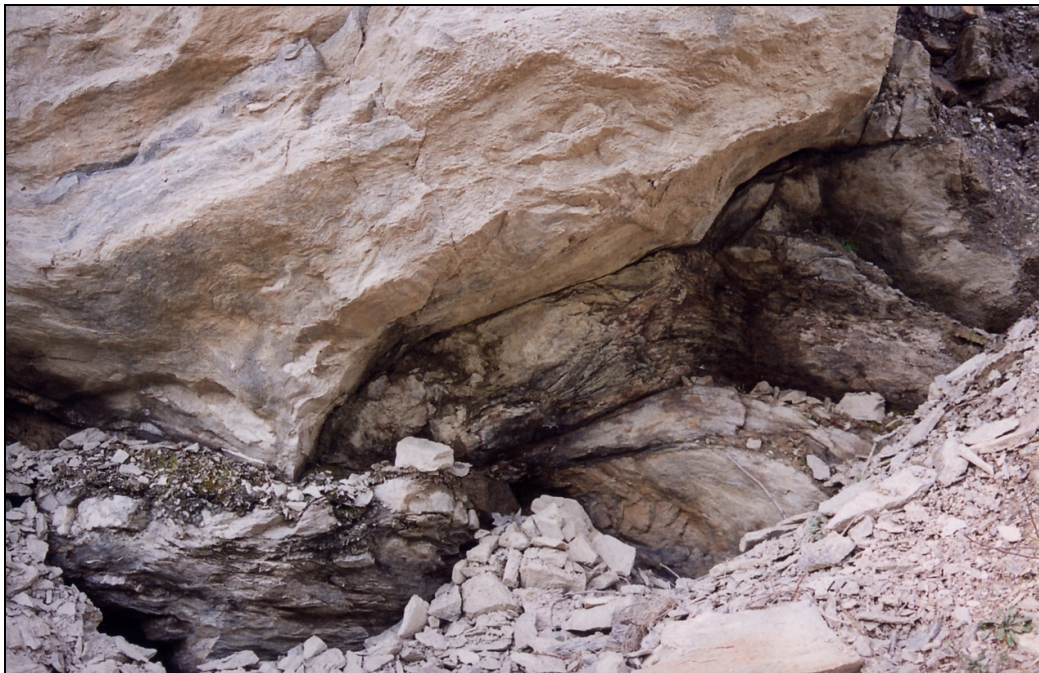
Abb. 6-6: Schieferungsparalleler Bewegungshorizont an der Basis der Marmorabfolge im zentralen Bereich der Aktivitätszone 1. Die feinblättrige Störungslette beziehungsweise -brekzie ist verfestigt, aber mit der Hammerspitze lösbar.
